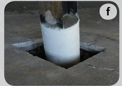
a. Daño por Corrosión   b. Aplique el epóxico al PileMedic™   c. Coloque el PileMedic™ alrededor de la columna o pilote para crear un encamisado cilíndrico
